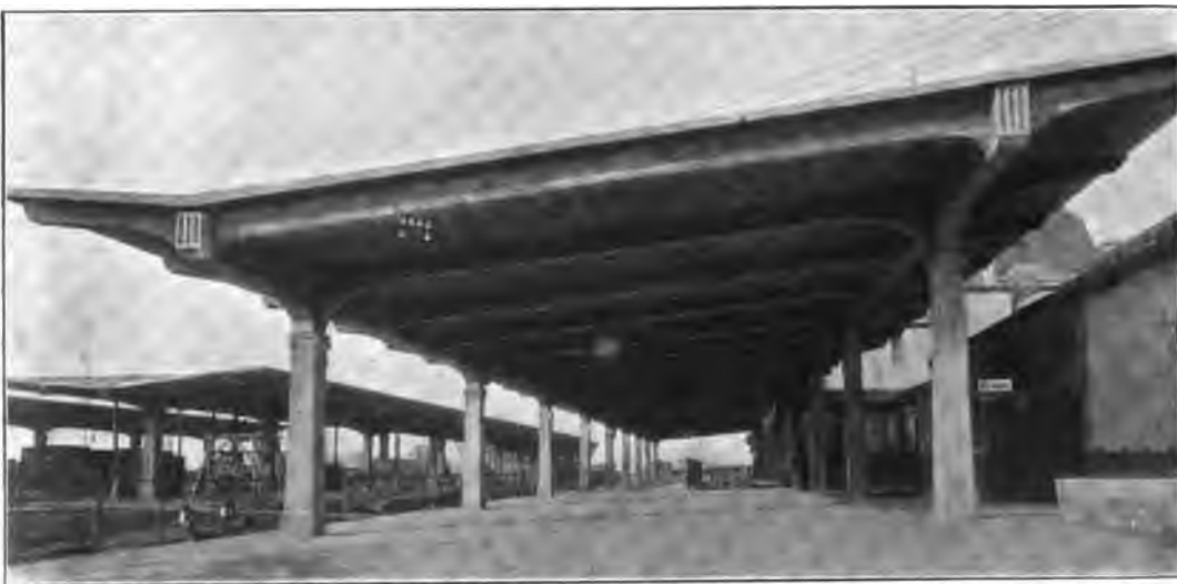
Abb. 95. Zweistielige Bahnsteighalle in Sonneberg, Thüringen.
